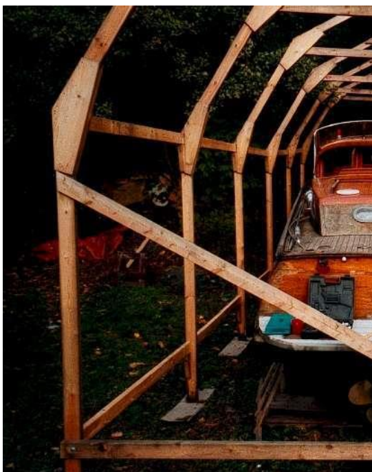
Exempel: Till vänster - båthus med regelvirke och plywood-hörn. Till höger – fast plåtbeslag.
